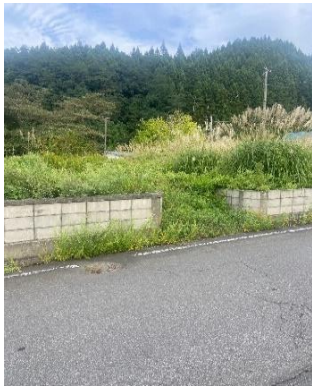
前面道路（南側）
