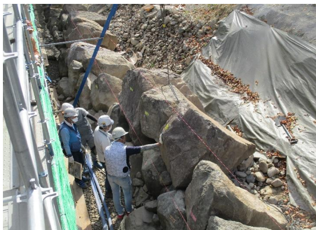
石垣積直し（令和3年10月4日撮影）
