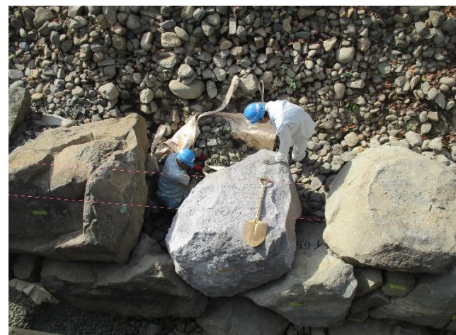
裏込め材投入（令和3年10月4日撮影）
