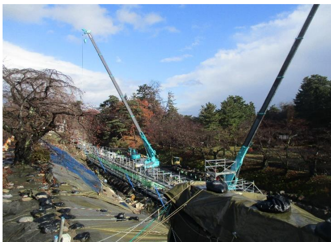
石垣積直し工事現場（令和3年11月11日撮影）
