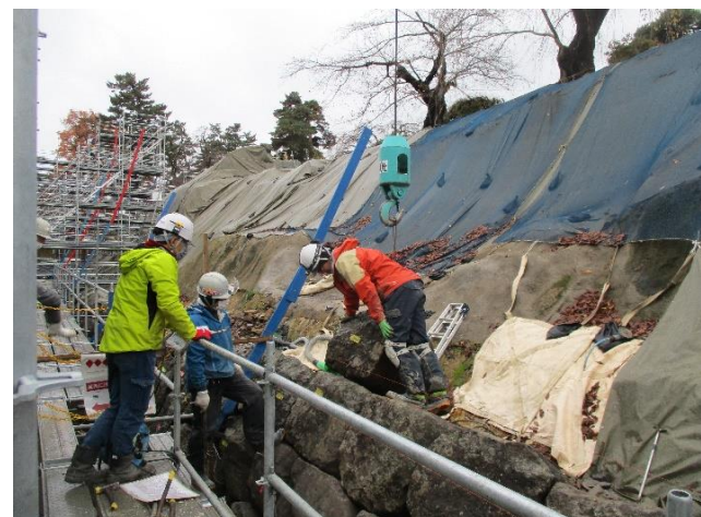
石垣積直し（令和3年11月12日撮影）
