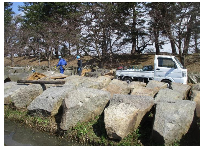
四の丸石材置き場での雪解け水処理
