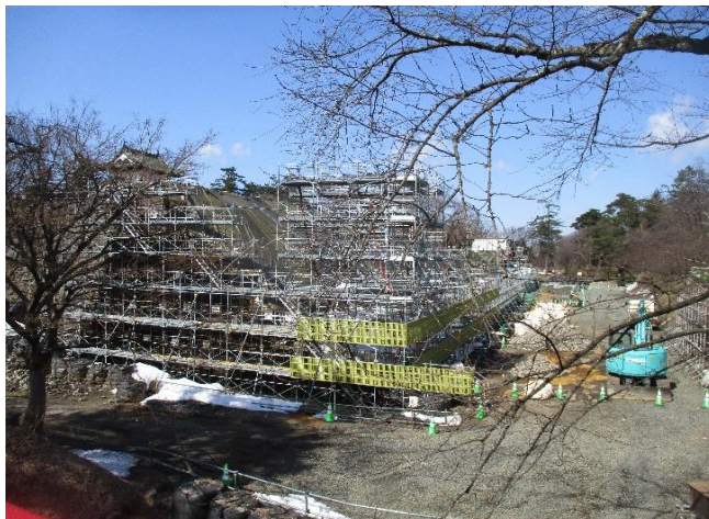
下乗橋から石垣修理現場を望む
