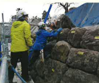
▲13段目の積み直しと12段目仮組み作業（※7）
