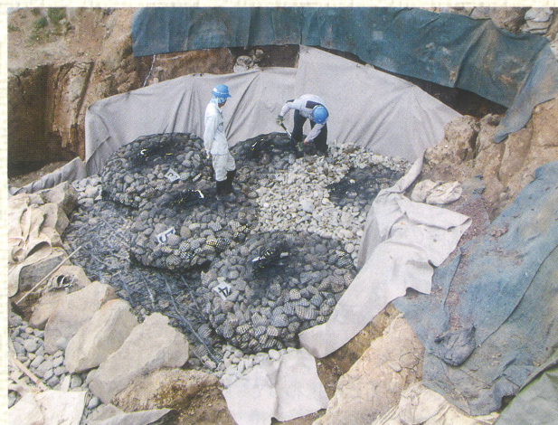
▲井戸跡に栗石を敷き詰める作業（※2）
