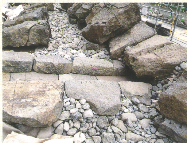
▲本丸の排水を流していた暗渠の復元（※3）
