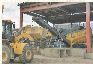
(※7) 破砕機で角礫に加工
