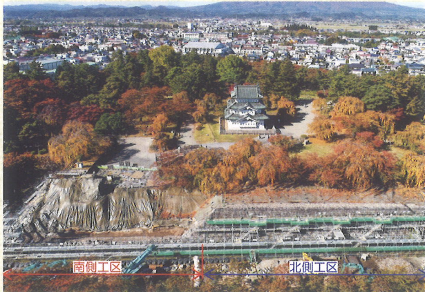
(※1) 令和5年10月末時点の石垣積直し状況
