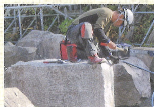
(※5) 交換石の仕上げ加工
