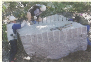
(※3) 調達した石材の粗割り作業
