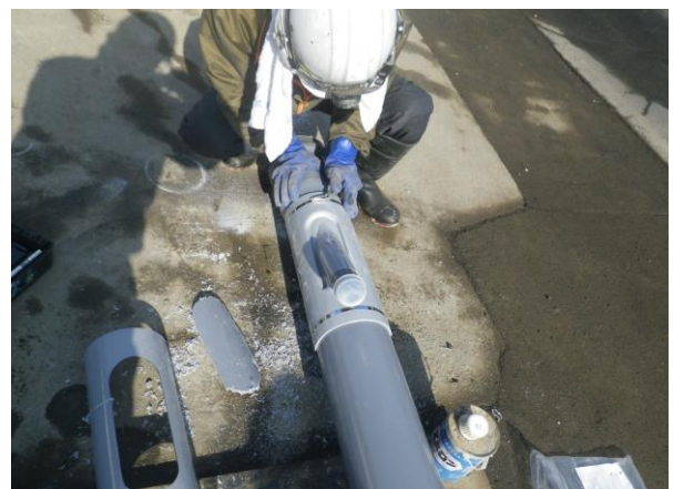
管路設置状況：分岐管の接合
