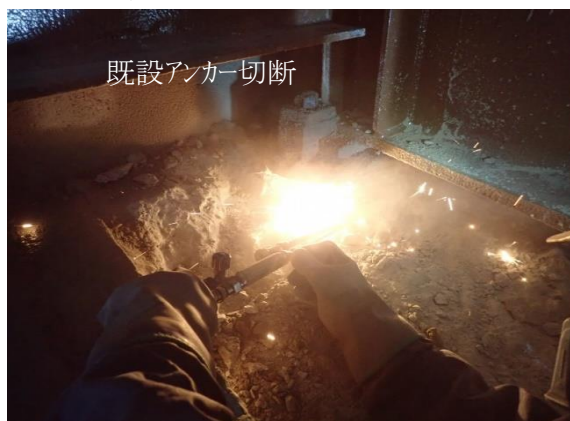
支承取替工 施工中
