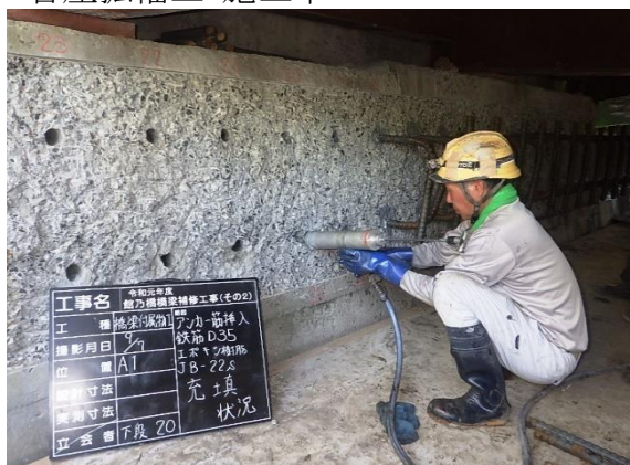
沓座拡幅工 施工中
