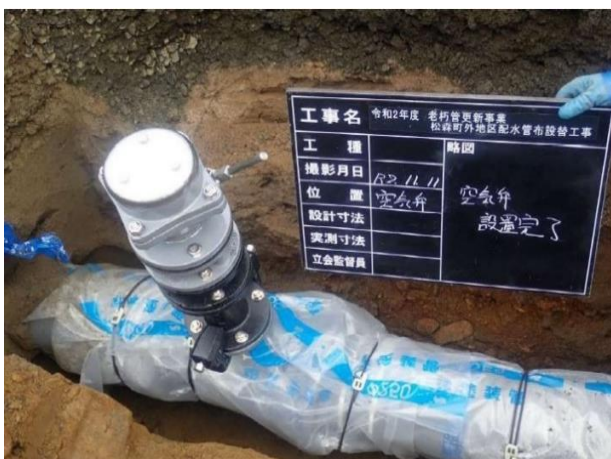
空気弁設置状況
