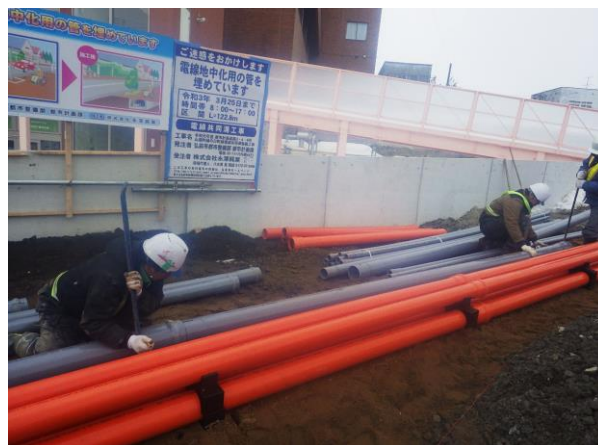
管路設置状況：挿入～接
