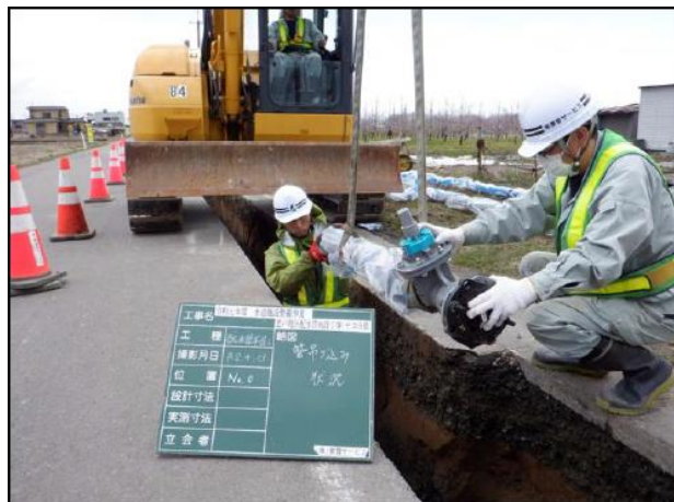
鋳鉄管吊込み据付
