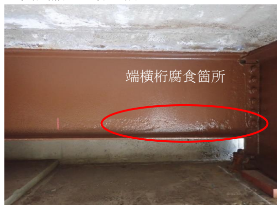
鋼桁補修工着工前
