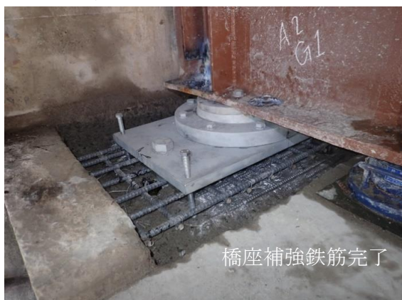
支承取替工 施工中
