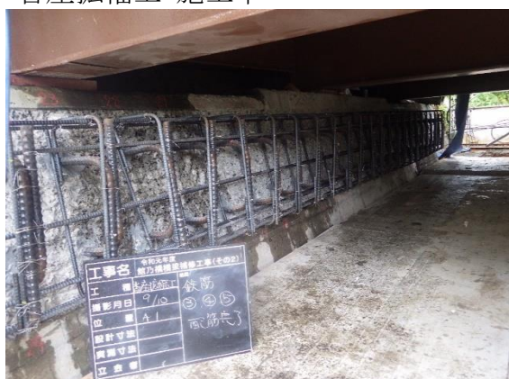
沓座拡幅工 施工中
