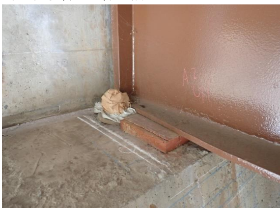
支承取替工 着工前
