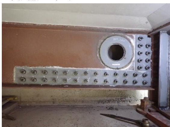
鋼桁補修工完了
