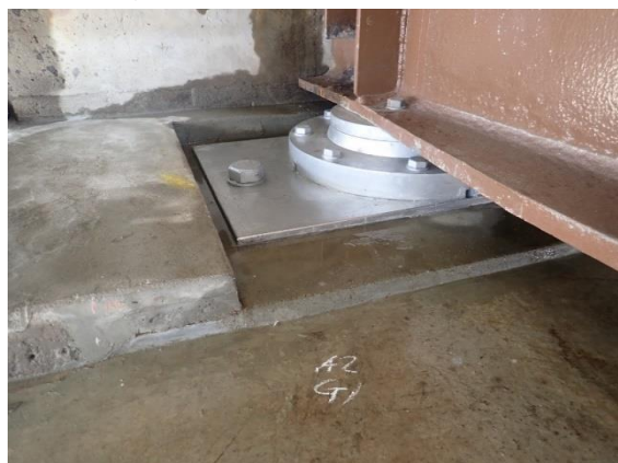
支承取替工 完了
