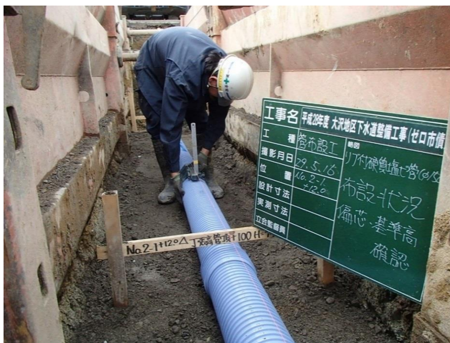
下水道整備工事の様子
