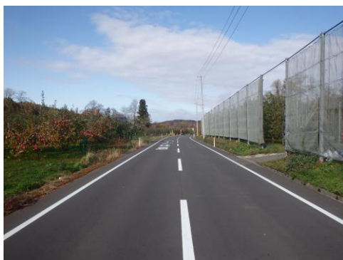
改修後の農道
