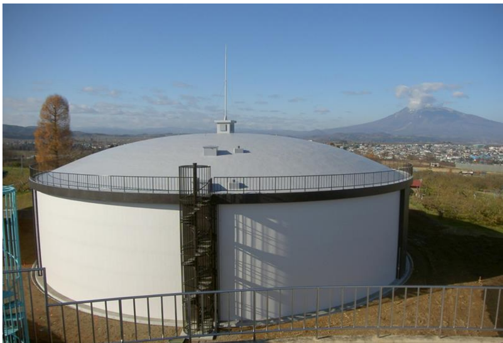
原ヶ平配水池
