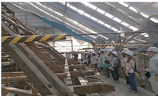
旧弘前偕行社保存修理の見学
