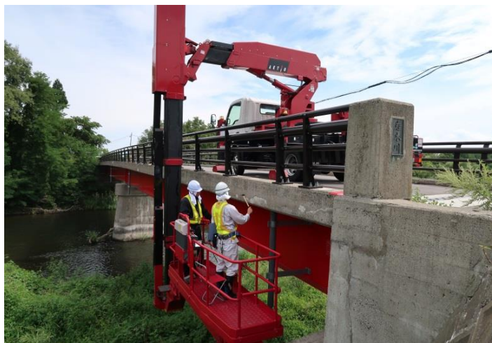
橋梁の点検の様子
