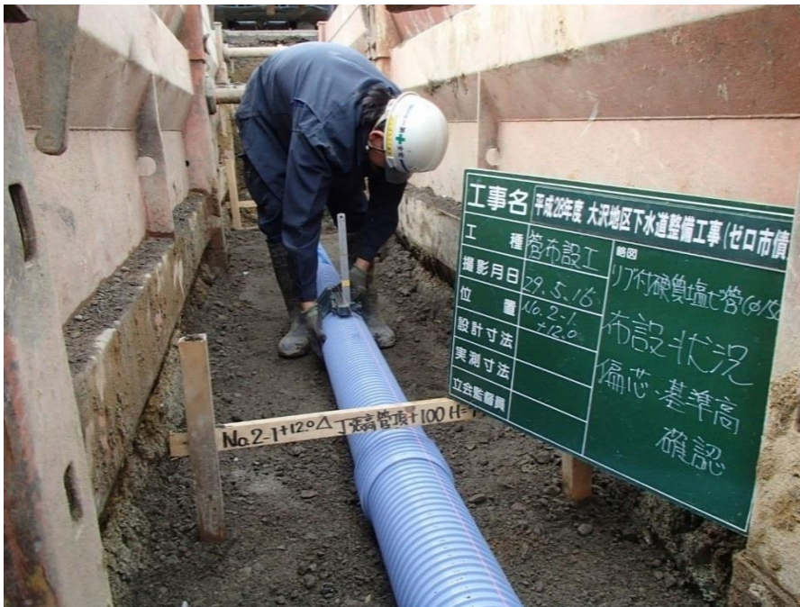
下水道整備工事の様子
