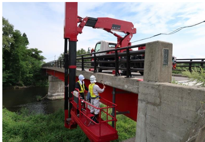
橋梁の点検の様子
