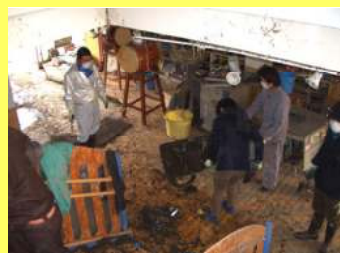
浸水した大槌町の幼稚園で清掃作業
