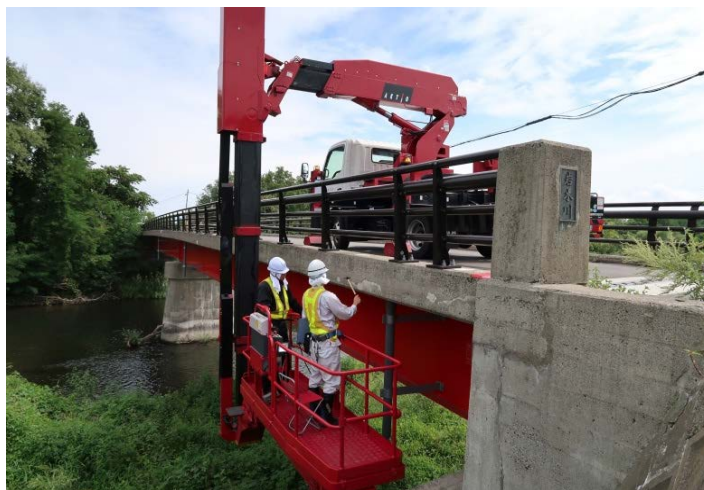
橋梁の点検の様子
