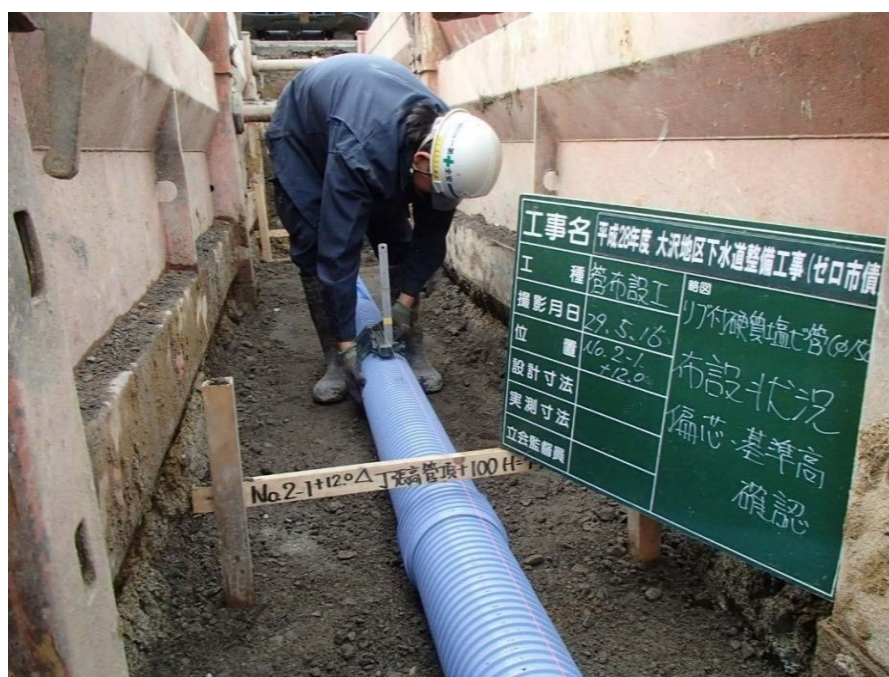
下水道整備工事の様子
