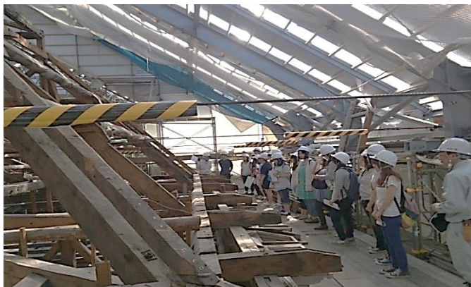
旧弘前偕行社保存修理の見学
