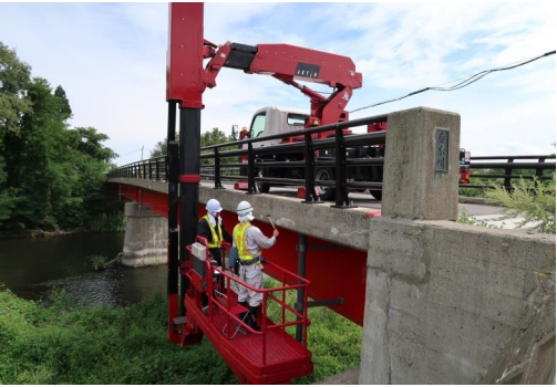
橋梁の点検の様子
