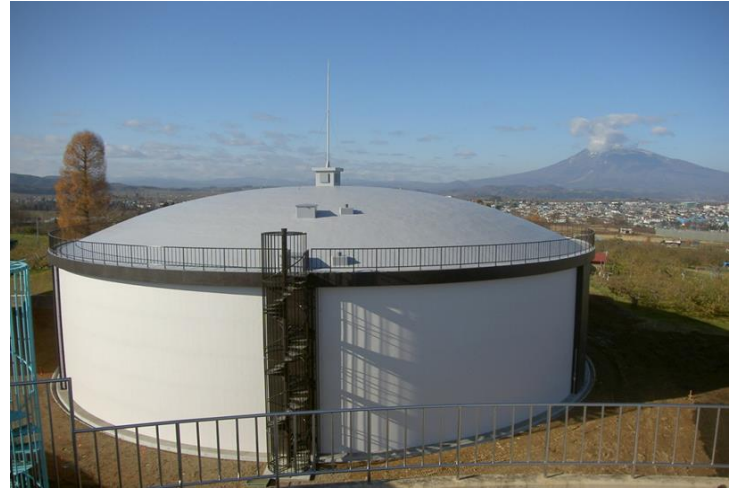
原ケ平配水池
