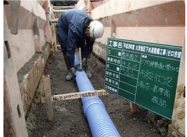
下水道整備工事の様子
