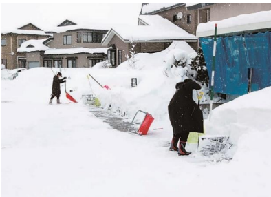
消流雪溝投雪状況
