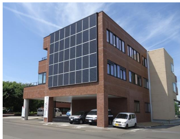
壁面に設置した太陽光パネル
