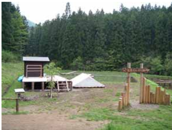
整備後 平成16年
