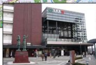
■弘前駅東西自由通路
