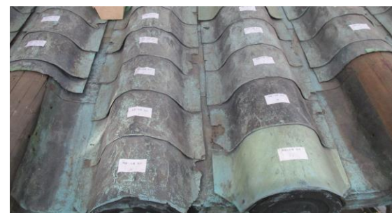
二の丸南門上層屋根妻側の銅瓦葺
