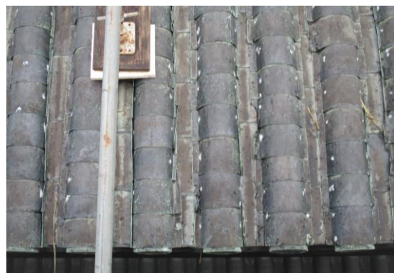
修理前の上層屋根南面 [追手門]
