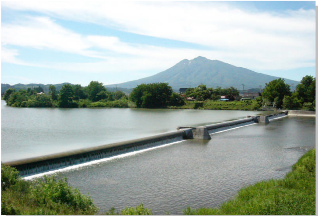
岩木川取水堰
