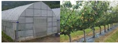
ハウス・樹園地の再整備・改修
