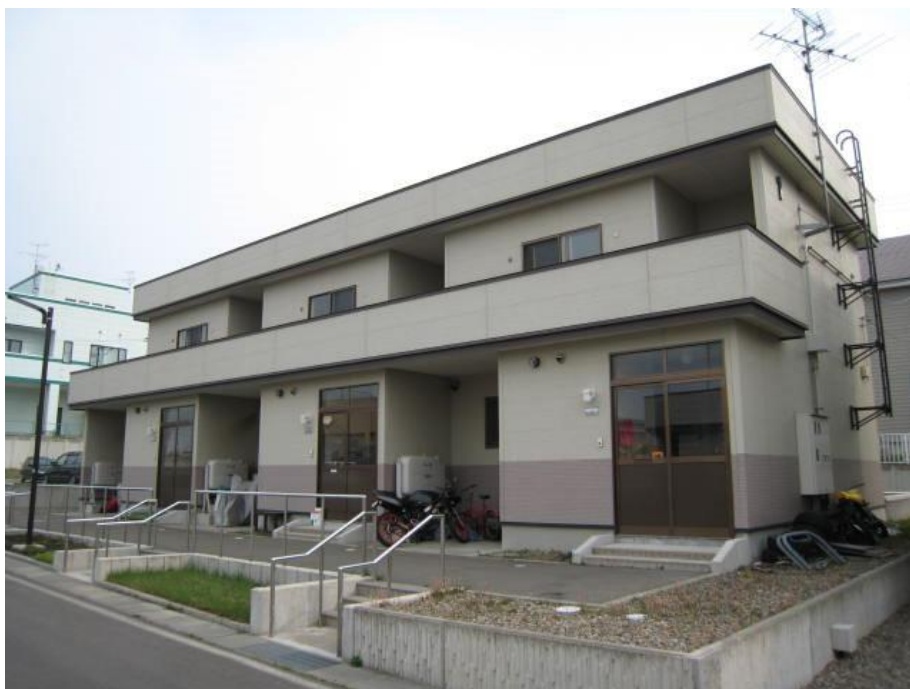
若葉一丁目団地外観写真（第1～7アパート）
