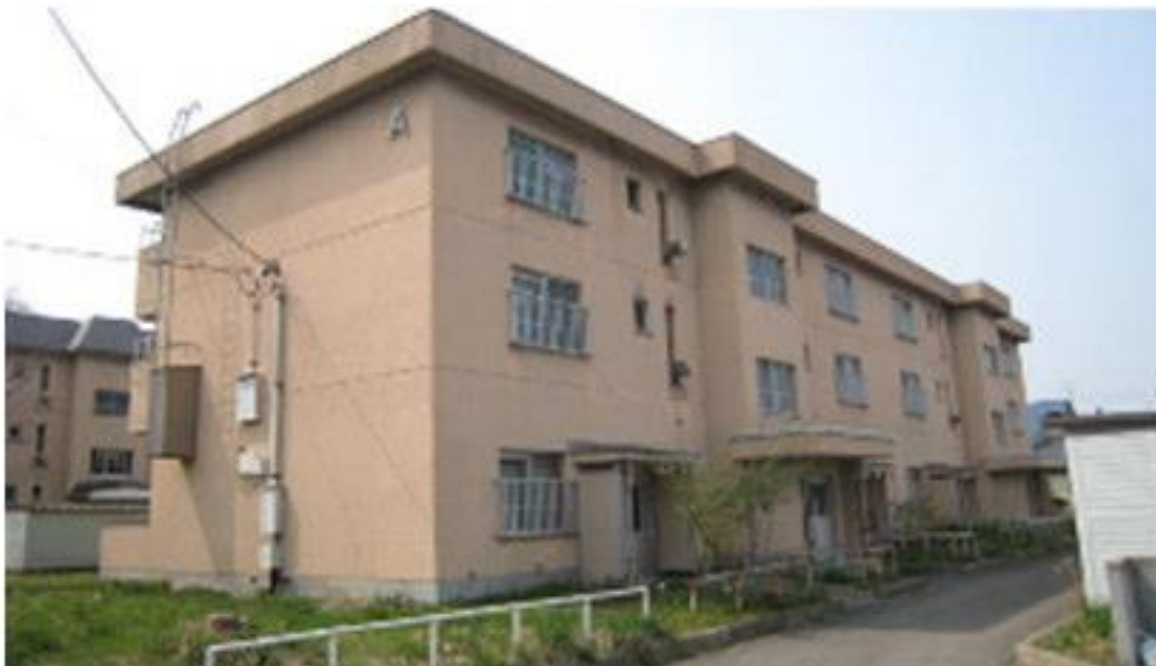
浜の町団地外観写真（A～Dアパート）
