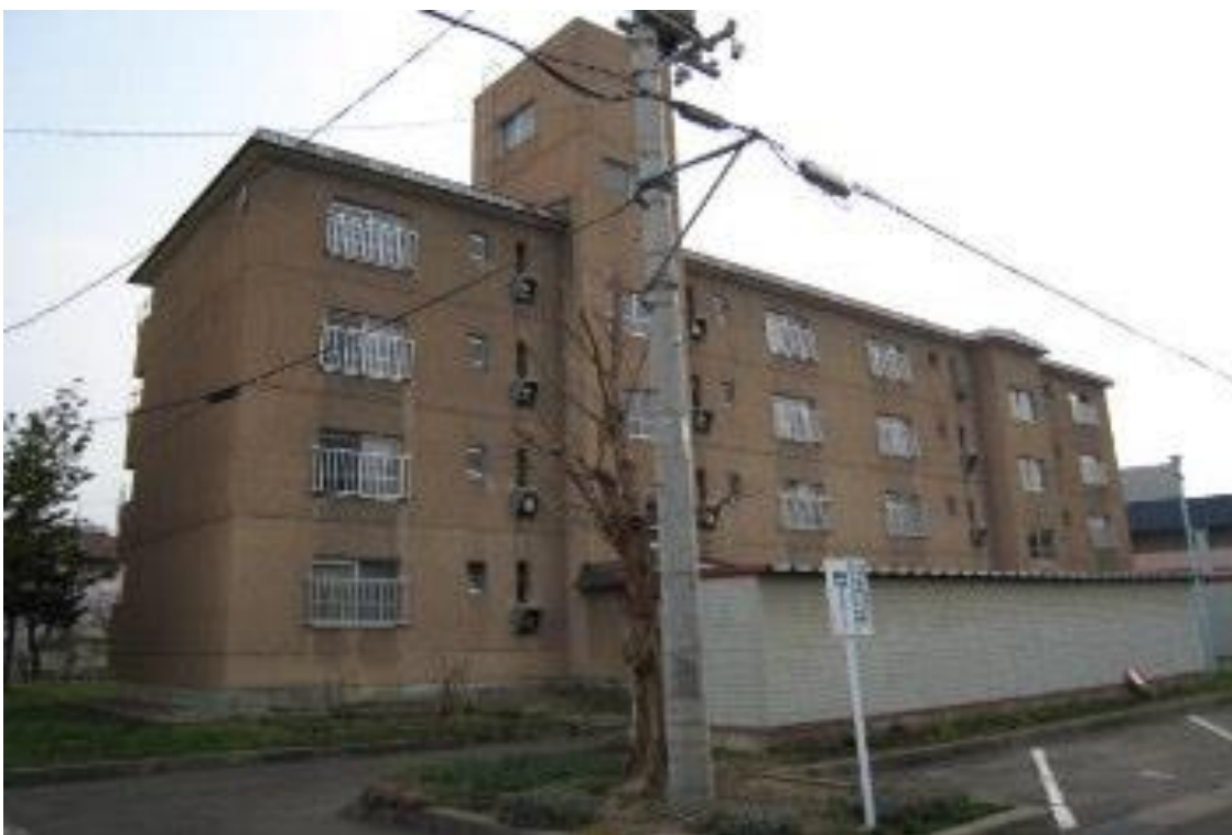
茂森団地外観写真（A、Bアパート）
