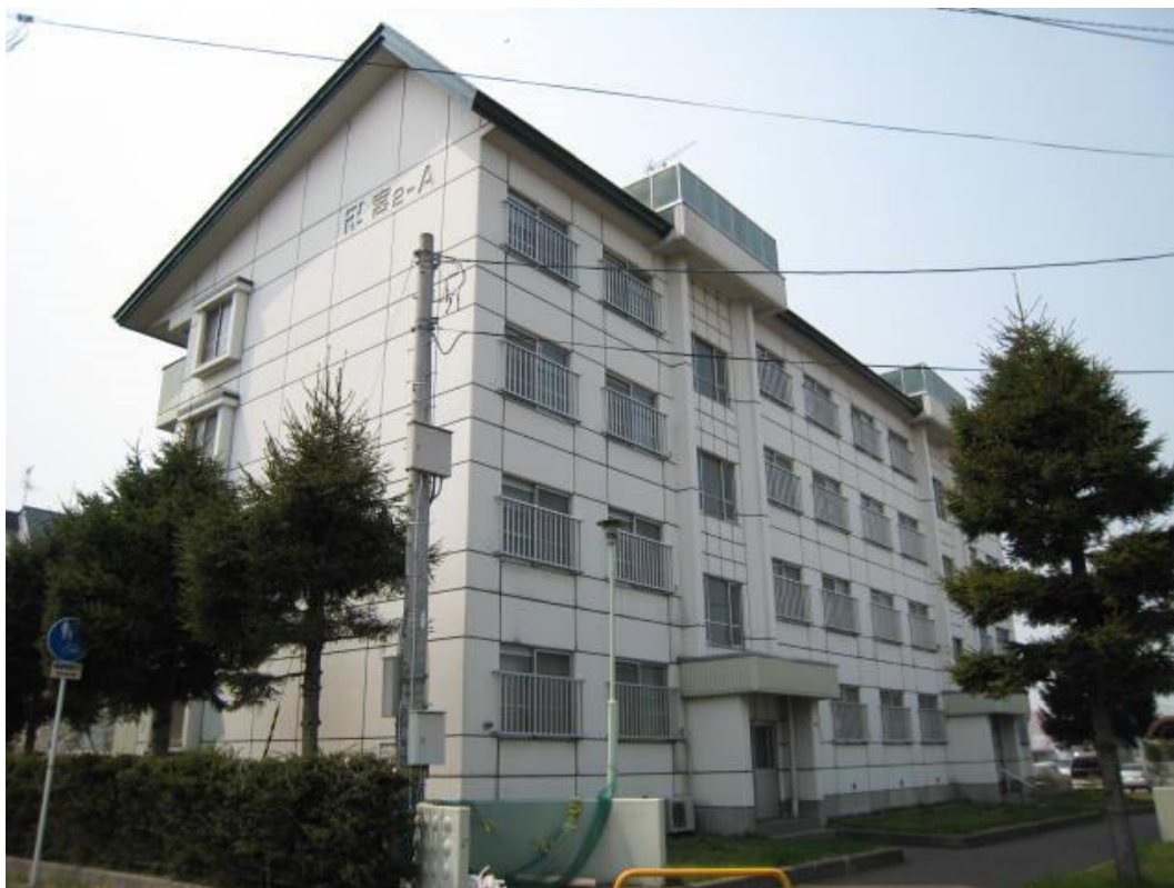
宮園第二団地外観写真（A～Eアパート）
