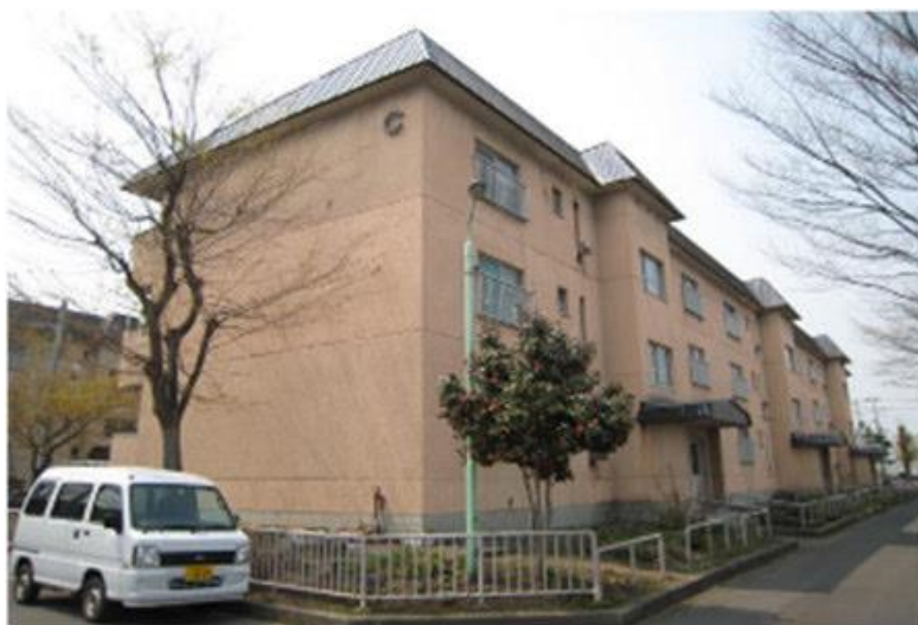
田町団地外観写真（A～Cアパート）
