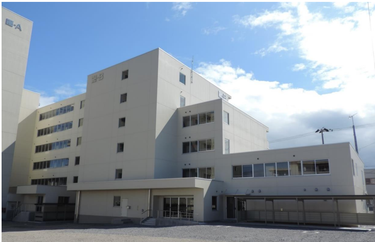
青葉団地外観写真（Bアパート）
