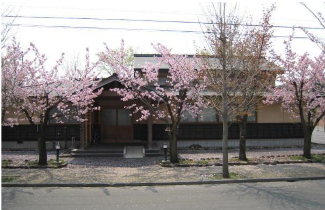
宮園第二団地集会所外観写真
