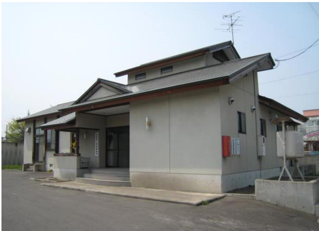
宮園第三団地集会所外観写真
