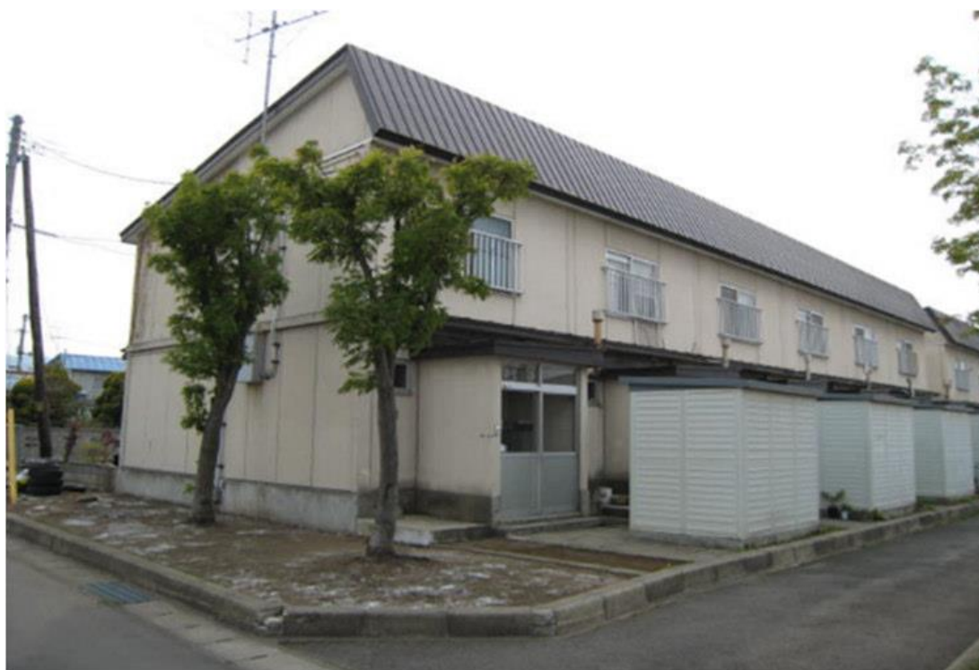
石川団地外観写真（第1～3アパート）
