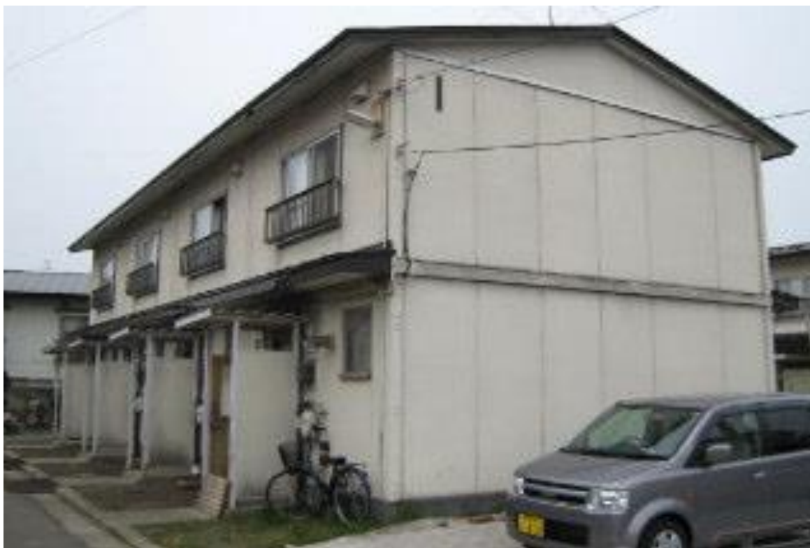
中野第二団地外観写真（第1～3アパート）
