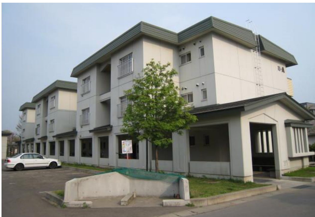
南城西団地外観写真（A～Cアパート）
