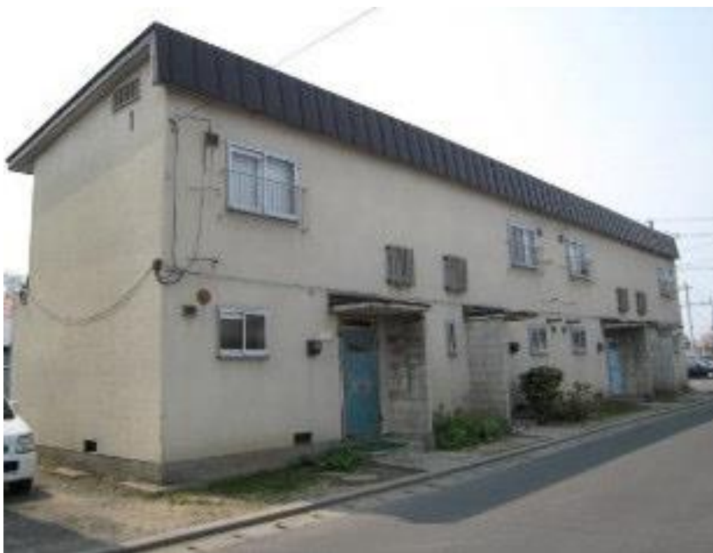
田町団地外観写真（第1～6アパート）
