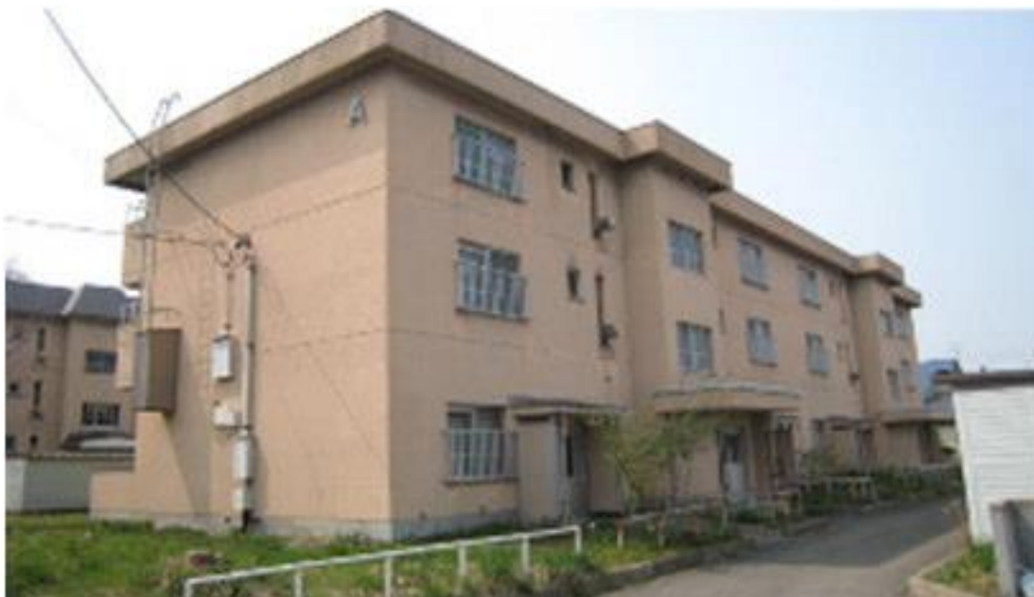
浜の町団地外観写真（A～Dアパート）
