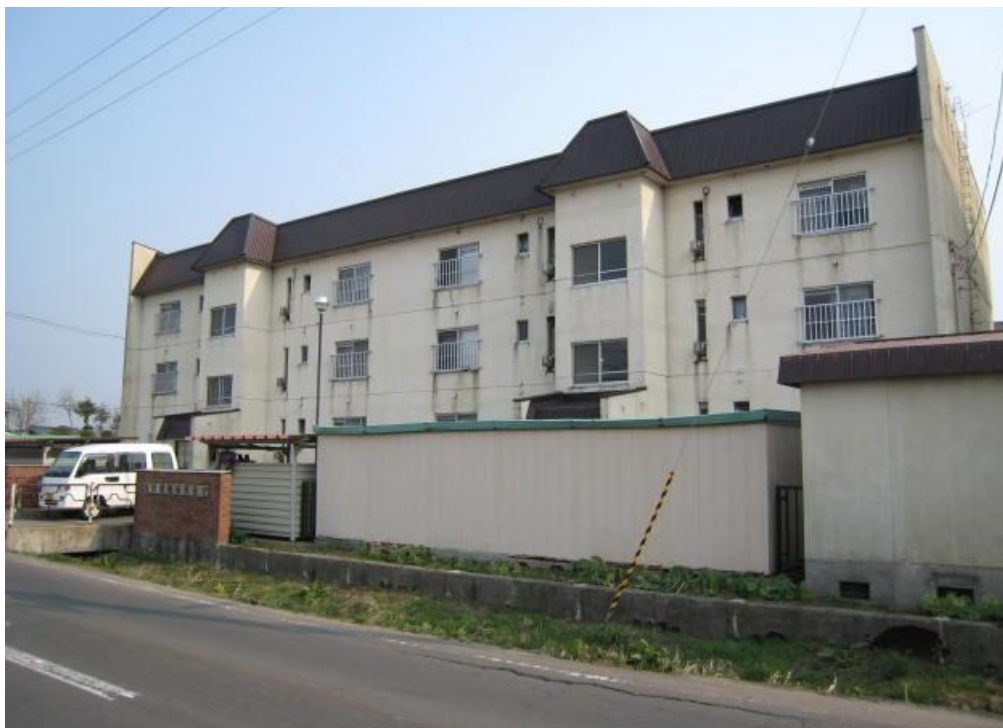
安田団地外観写真（81、82太陽棟・81、82あすなろ棟）
