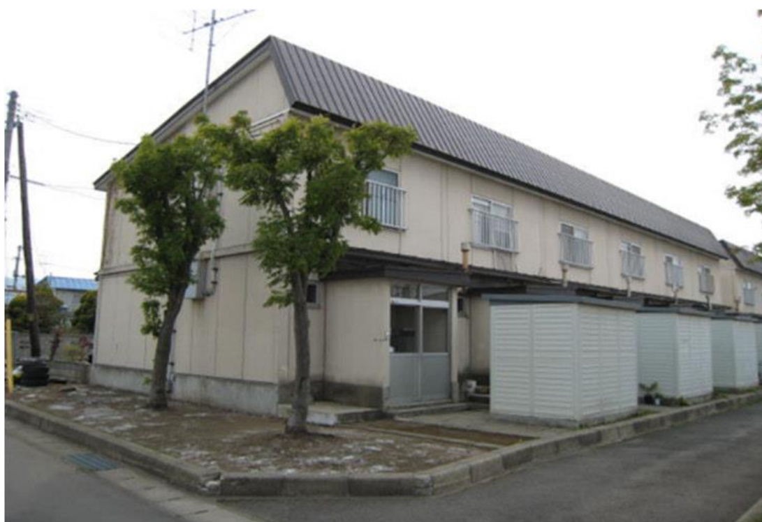
石川団地外観写真（第1～3アパート）
