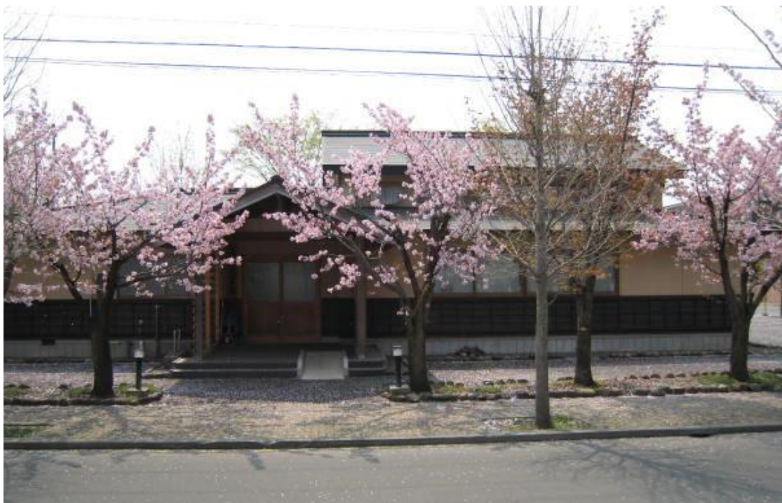
宮園第二団地集会所外観写真
