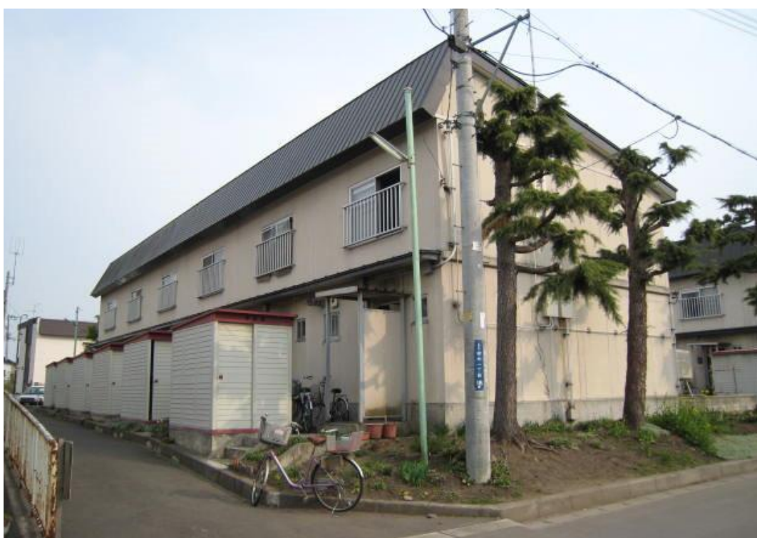
樹木団地外観写真（第1、2アパート）
