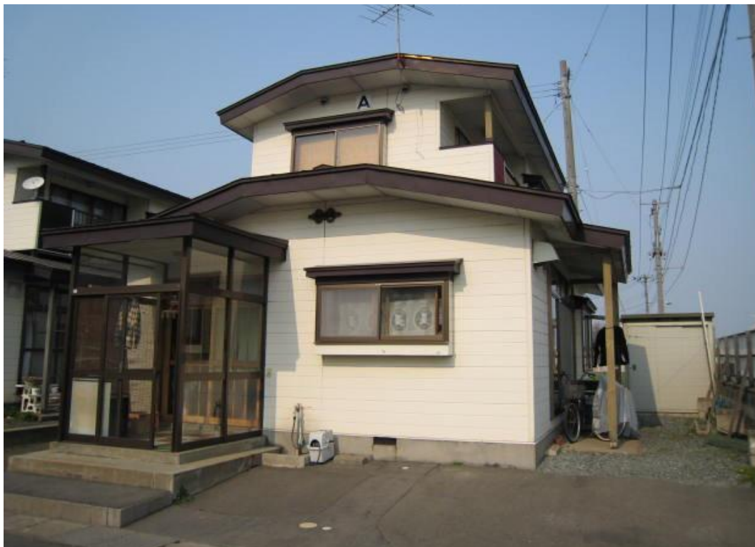
賀田団地外観写真（A～Z、α～α2、夢1～6、彩1～7棟）
