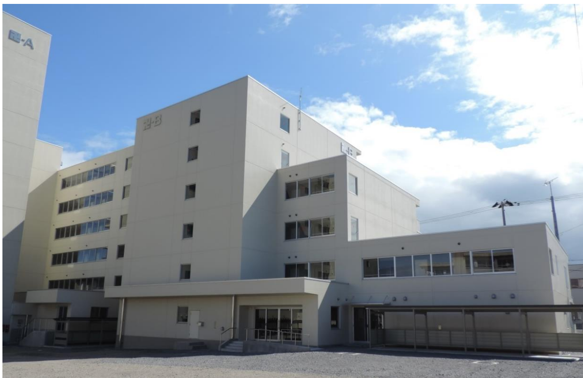
青葉団地外観写真（Bアパート）
