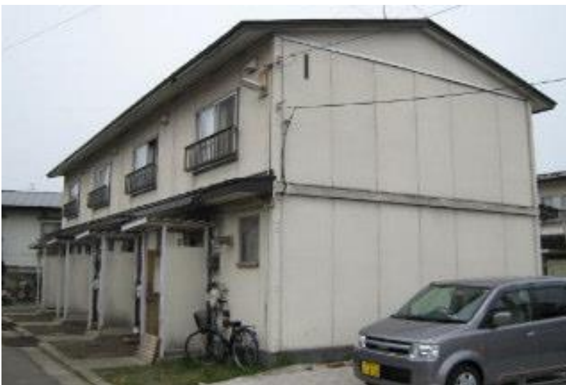
中野第二団地外観写真（第1～3アパート）
