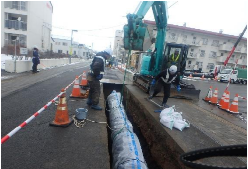
水道管の布設替工事
