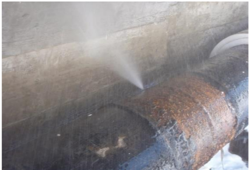
老朽化した水道管からの漏水
