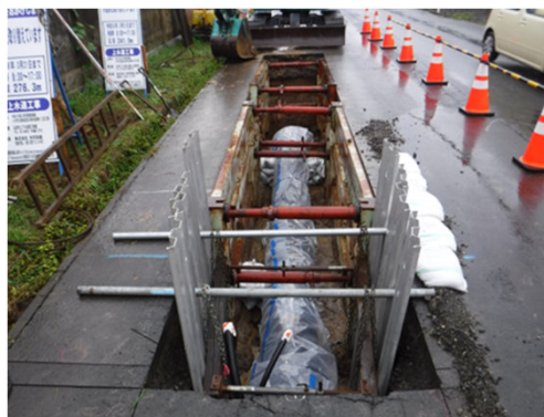
【上水管路耐震管の布設状況】
