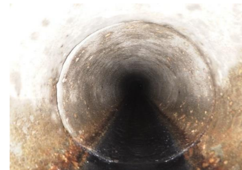
老朽化した下水管の内部
