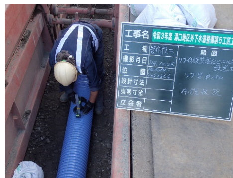
【下水道管路耐震管の布設状況】
