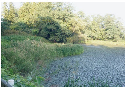
廃止工事が行われる高岡溜池
