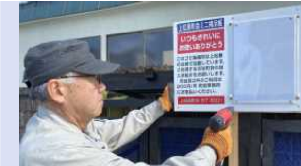
掲示板設置作業の様子
