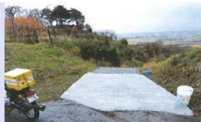
自分たちの手で舗装作業を実施
