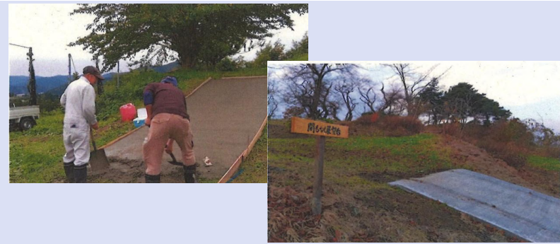
自分たちの手で舗装作業を実施しました
