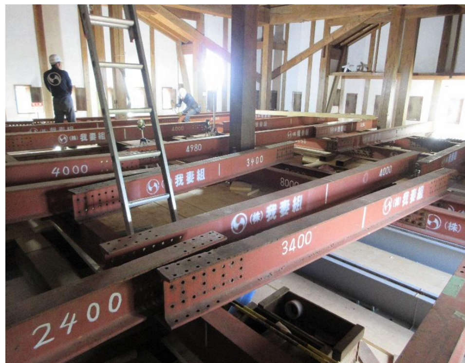
令和8年6月1日時点の状況写真
