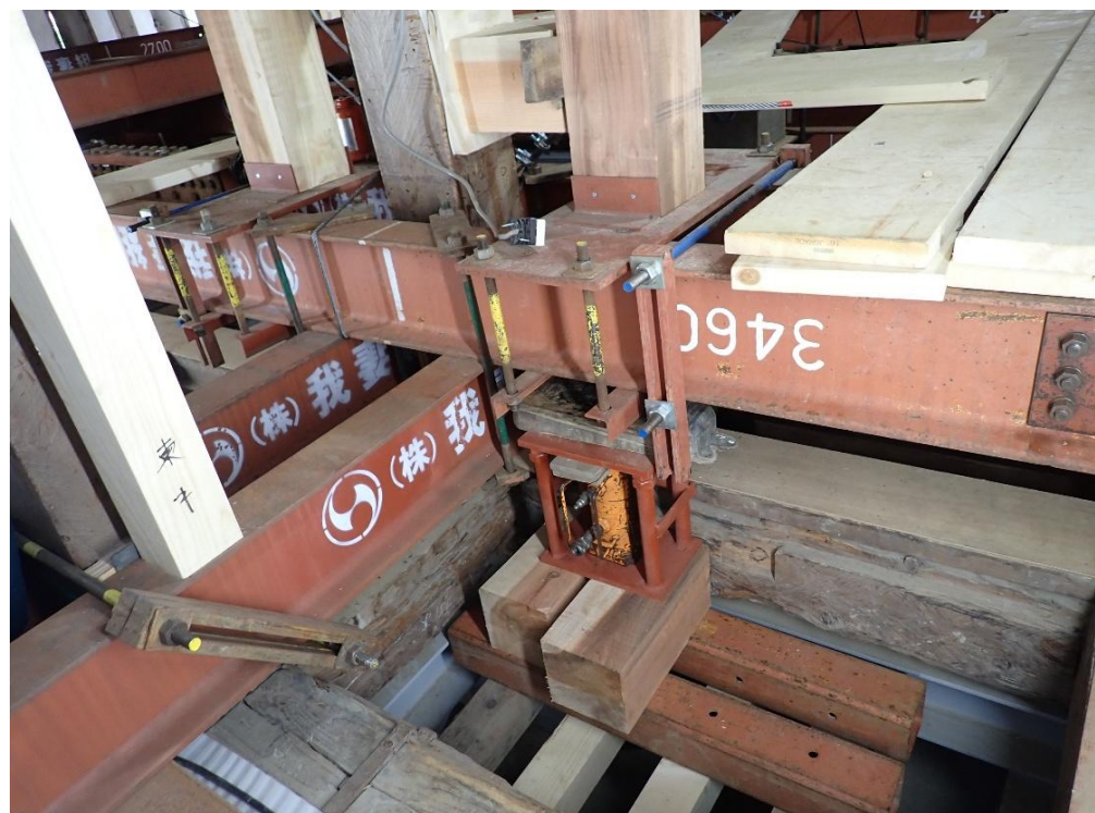
令和8年6月10日時点の状況写真 【揚家用ジャッキ設置】
