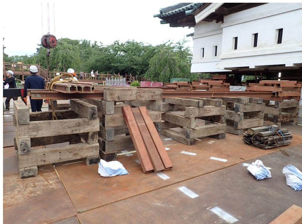
令和8年6月24日時点の状況写真 【1次移動用レール設置（天守東側）】
