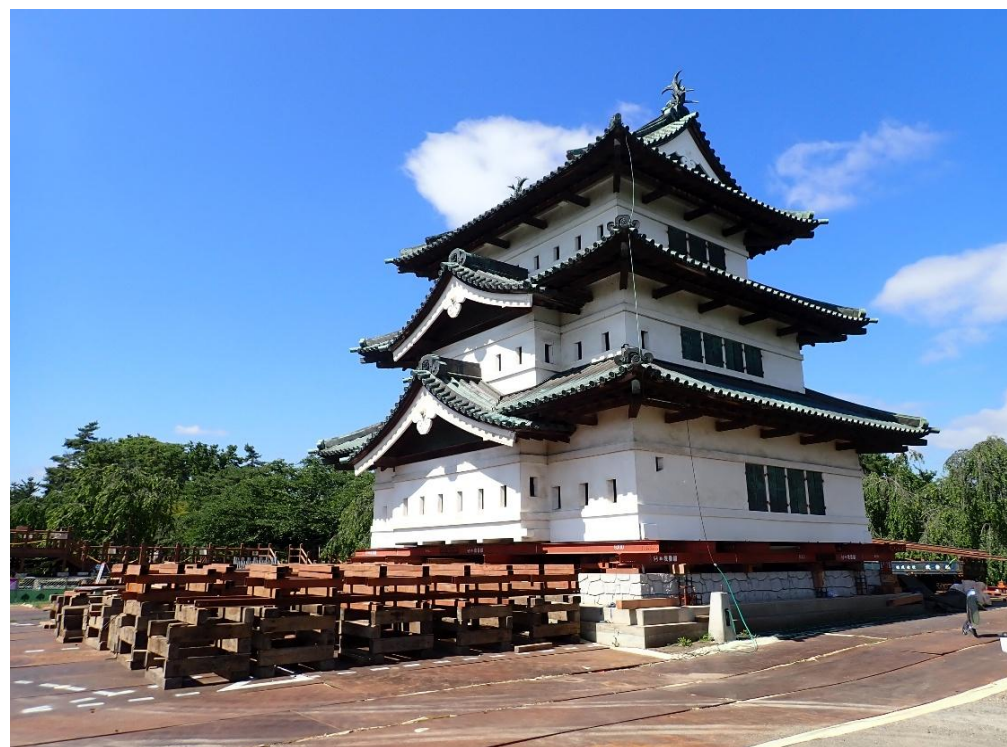
令和8年6月29日時点の状況写真 【1次移動用レール設置（天守東側）】
