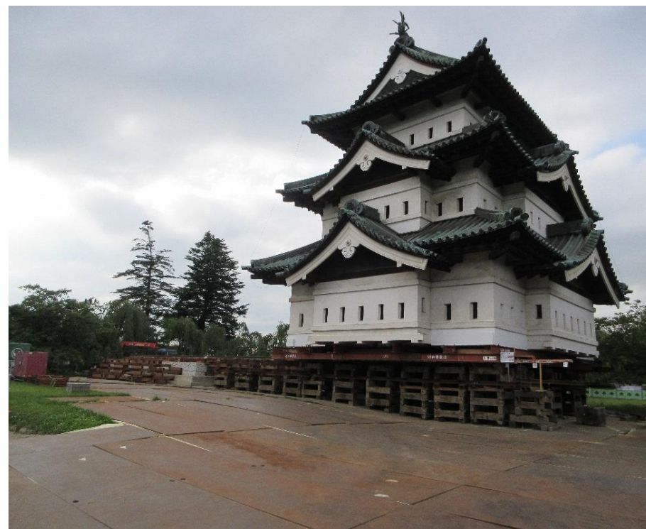
令和8年7月6日時点の状況写真 【1次移動終了（天守南面）】
