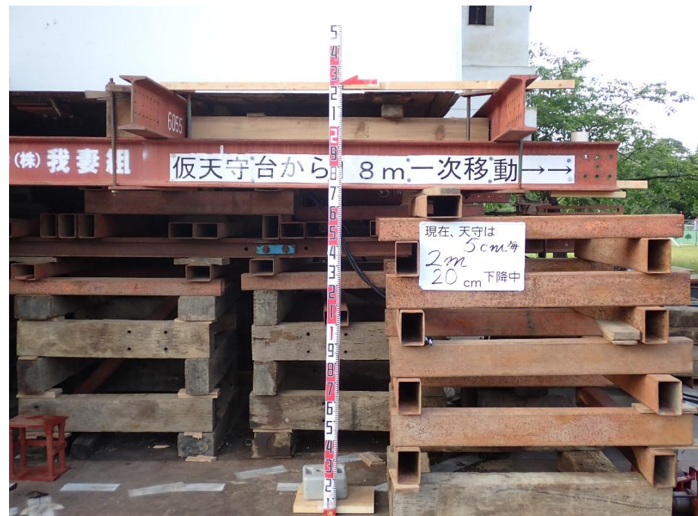
令和8年7月10日時点の状況写真 【天守下家（天守南東角）】
