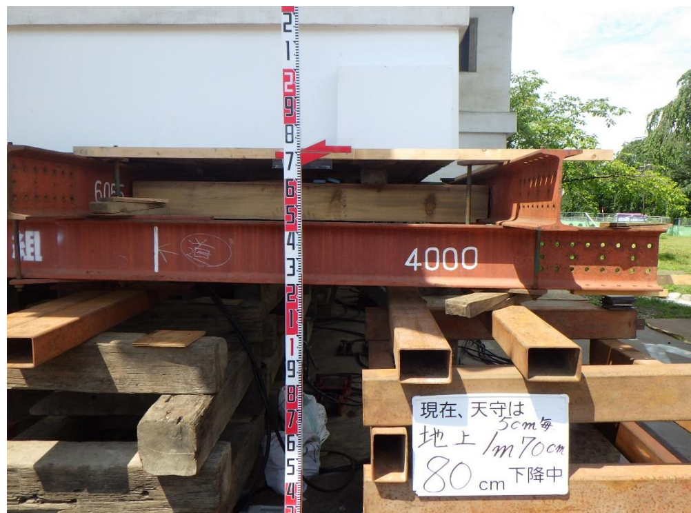
令和8年7月17日時点の状況写真 【天守下げ家終了（天守南東角高さ2.5mから80cm下げ家）】
