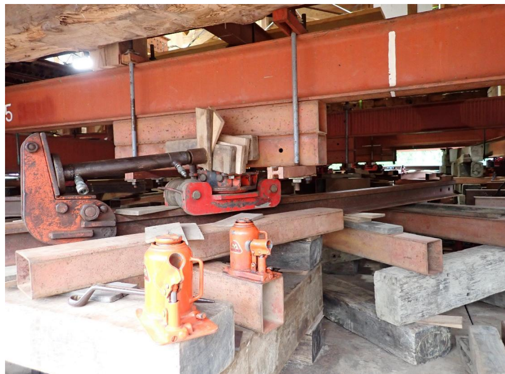
令和8年7月24日時点の状況写真 【一次回転準備（推進用ジャッキ・ローラー・レール設置状況）】
