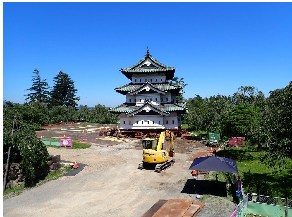
令和8年8月3日時点の状況写真
