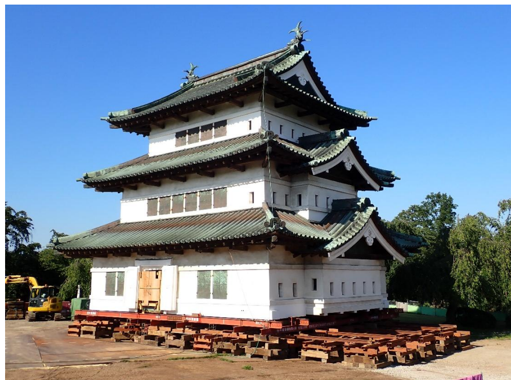
令和8年8月7日時点の状況写真
