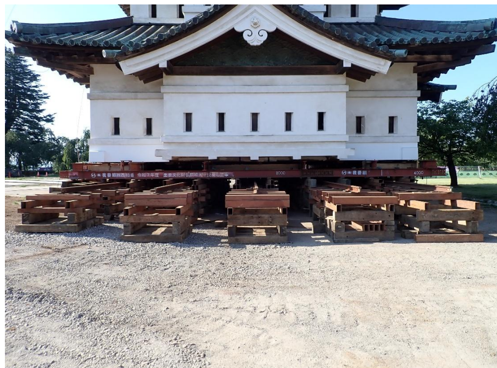
令和8年8月17日時点の状況写真
