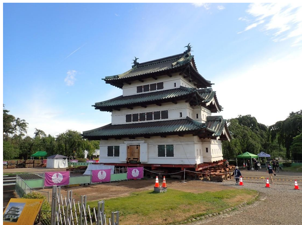
令和8年8月31日時点の状況写真 【二次移動中（一次移動先から4.67m南へ移動）】
