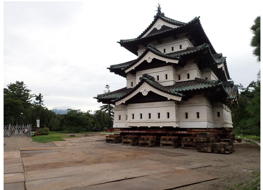
令和8年9月7日時点の状況写真 【二次移動中（一次移動先から4.67m南へ移動）】
