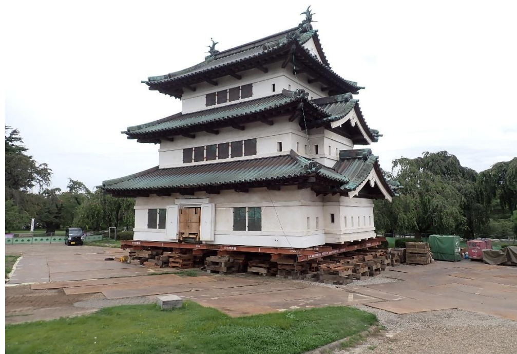
令和8年9月15日時点の状況写真 【二次移動中（一次移動先から4.67m南へ移動）】
