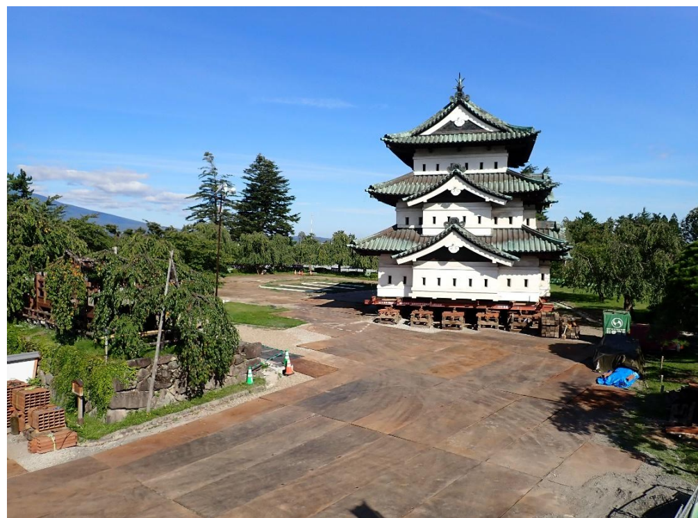
令和8年9月18日時点の状況写真 【二次移動中（一次移動先から4.67m南へ移動）】
