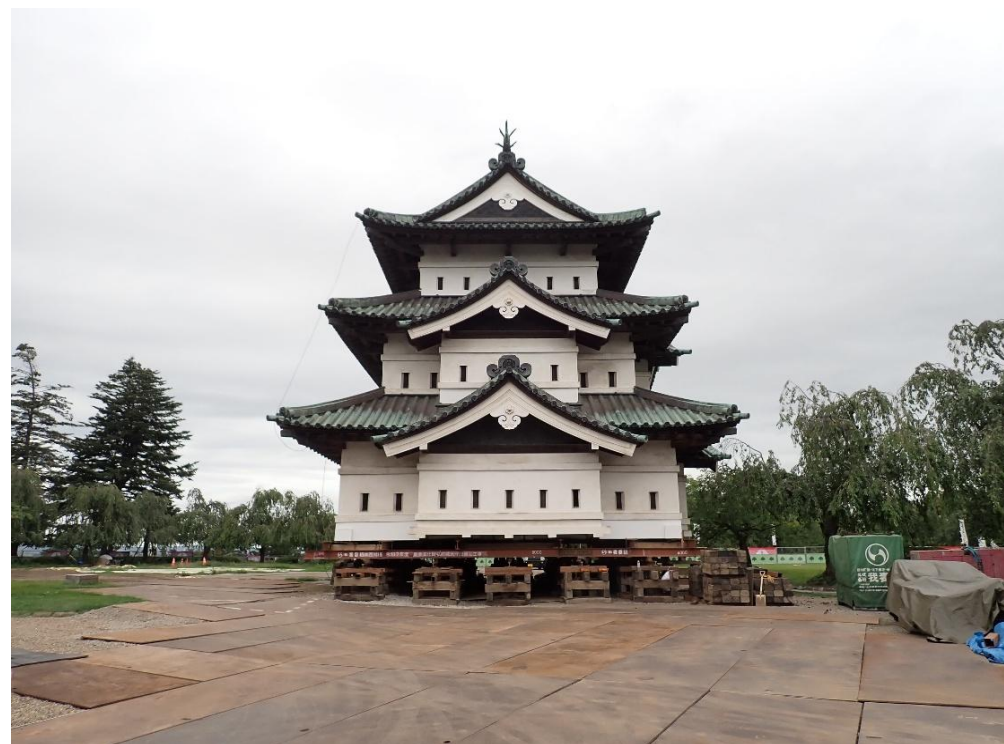
令和8年9月25日時点の状況写真 【二次移動中（一次移動先から4.67m南へ移動）】
