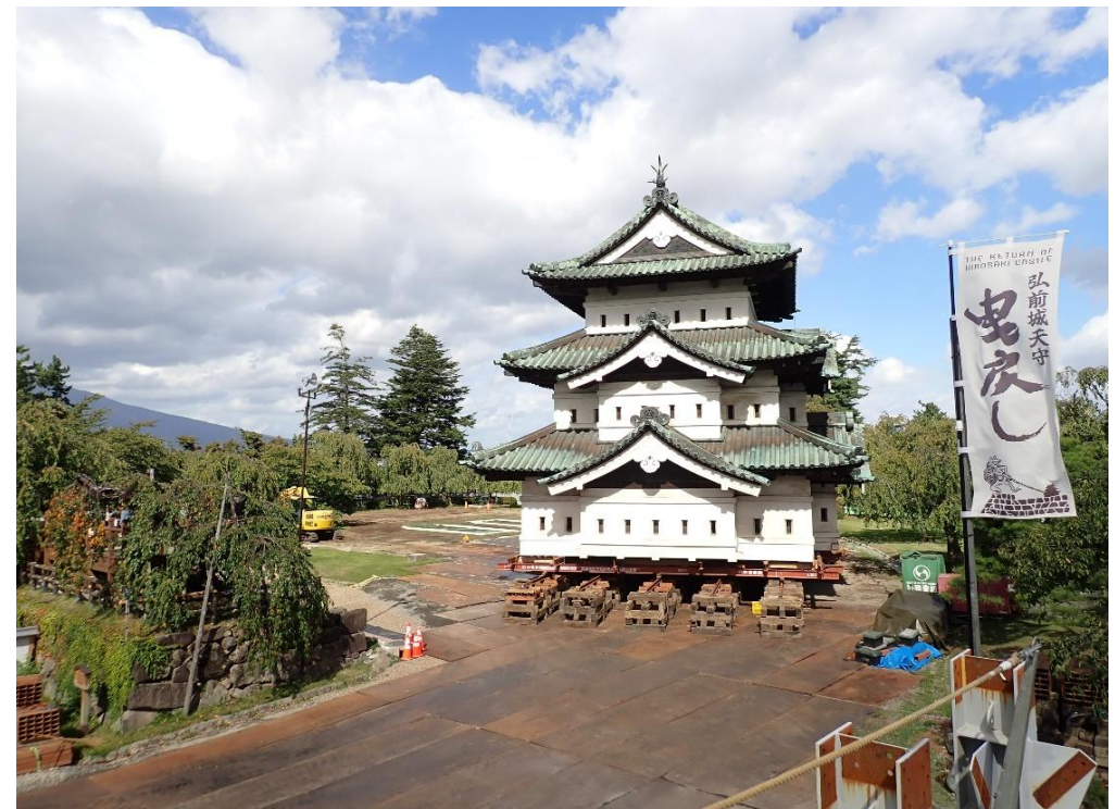
令和8年10月2日時点の状況写真 【二次移動中（一次移動先から11.12m南へ移動）】
