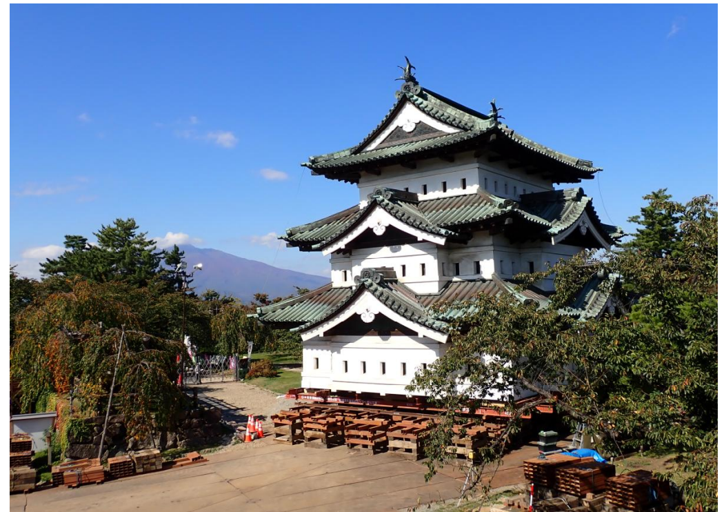
令和8年10月13日時点の状況写真 【二次移動中（一次移動先から15.99m南へ移動）】
