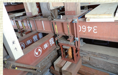
▲(※4) 揚家用ジャッキ設置状況
