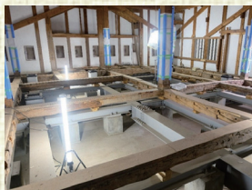
▲(※3) 仮補強鉄骨と床板の取外し(天守1階)
