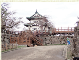
▲(※2) 仮設通路の設置
