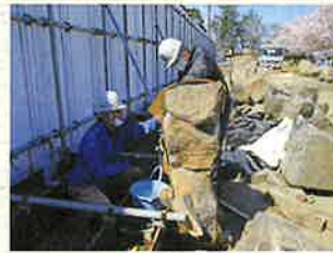
▲(※4) 割れた石の補修
