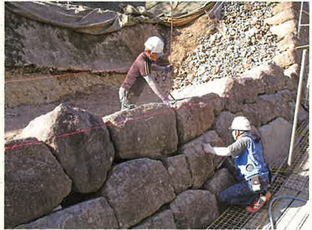
▲(※3) 丁張(ちょうはり)と石積み作業
