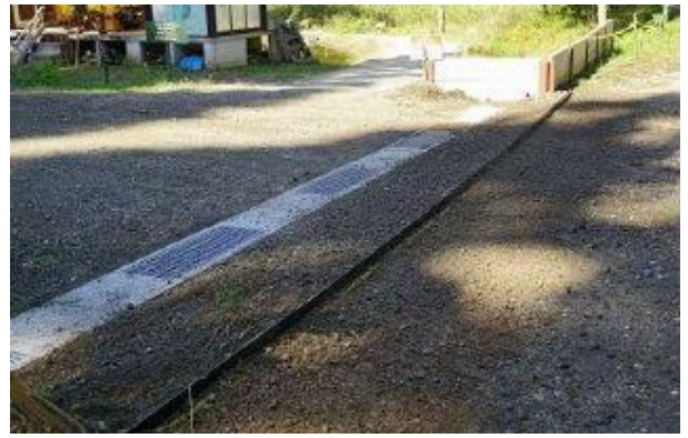
雨水導水用ゴム板敷設完成
