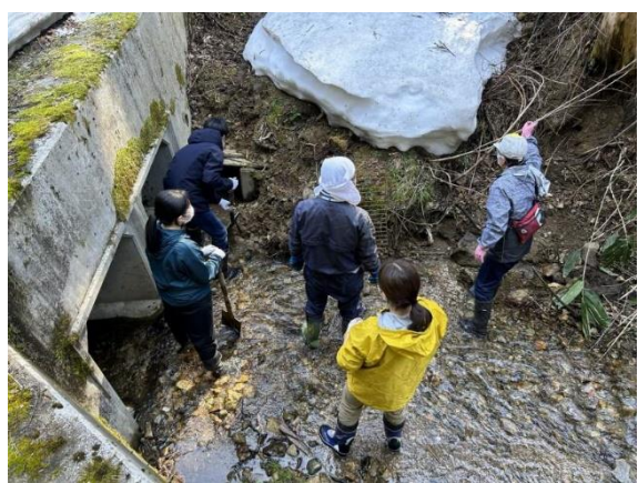
赤沢カナコ菰導水管点検閉塞除去
