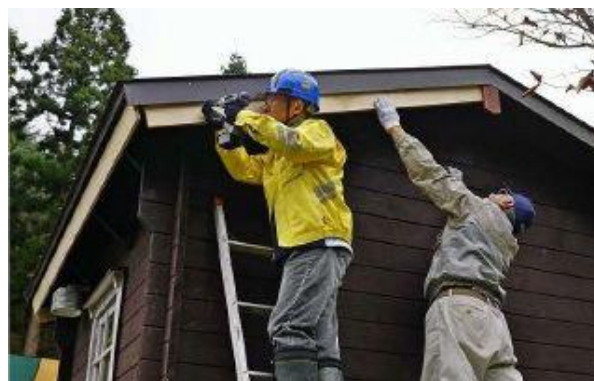
屋根軒下シート押え板の取付け
