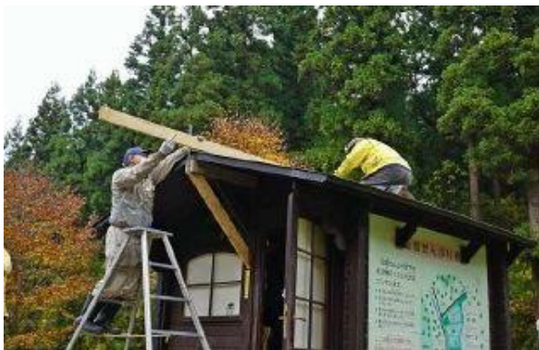
作業小屋屋根に雪割り板の取付け
