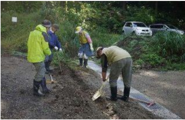
ゴム板を側溝前に埋設
