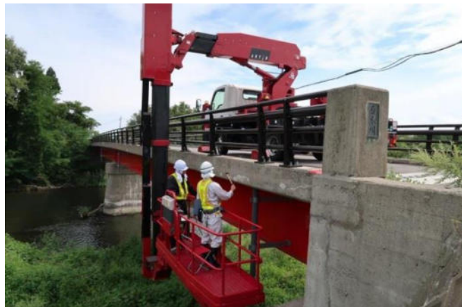
橋梁の点検の様子
