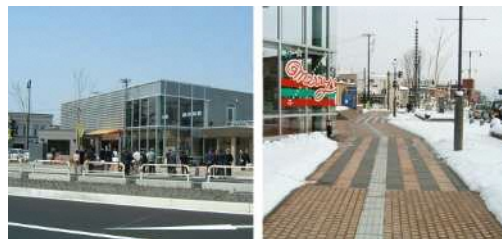
図 8-16 まちなか情報センターでの 地中熱による融雪
