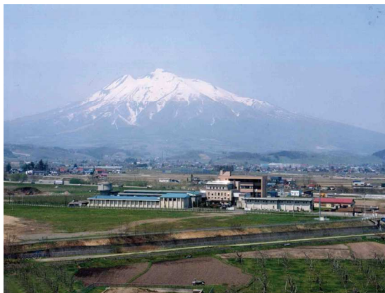
【樋の口浄水場(全体)】
