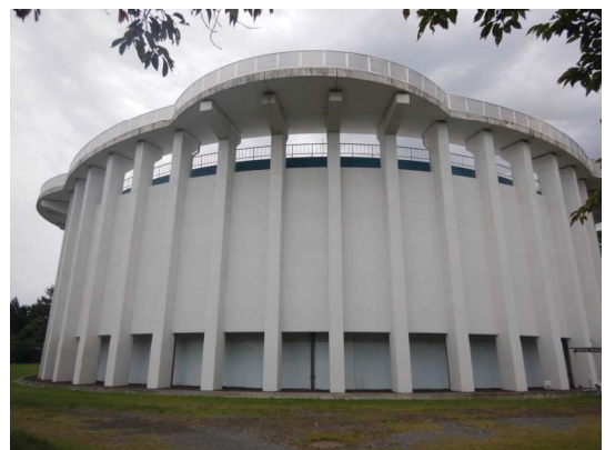
【常盤坂配水池】
