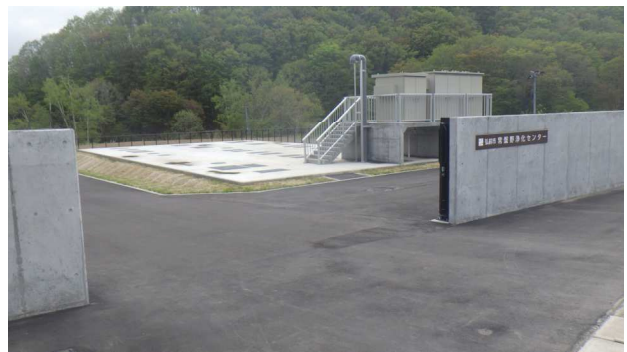
【常盤野浄化センター】
