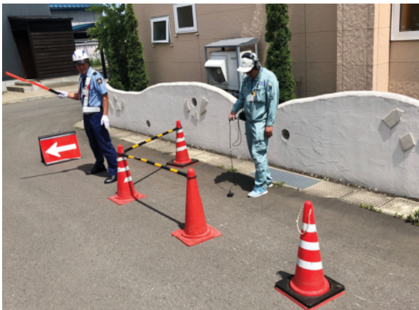
【漏水調査状況】
