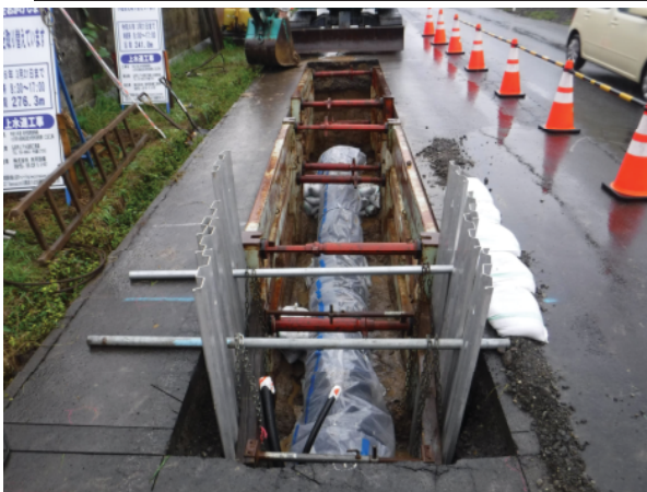
【上水管路耐震管布設状況】
