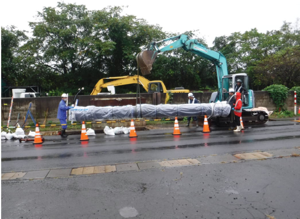
【水道管の布設状況】
