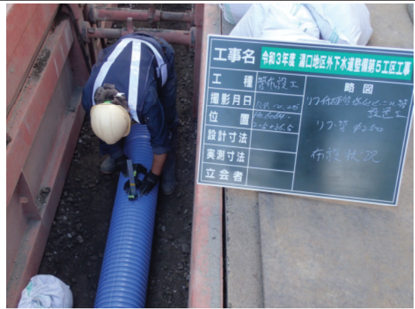
【下水管路耐震管布設状況】
